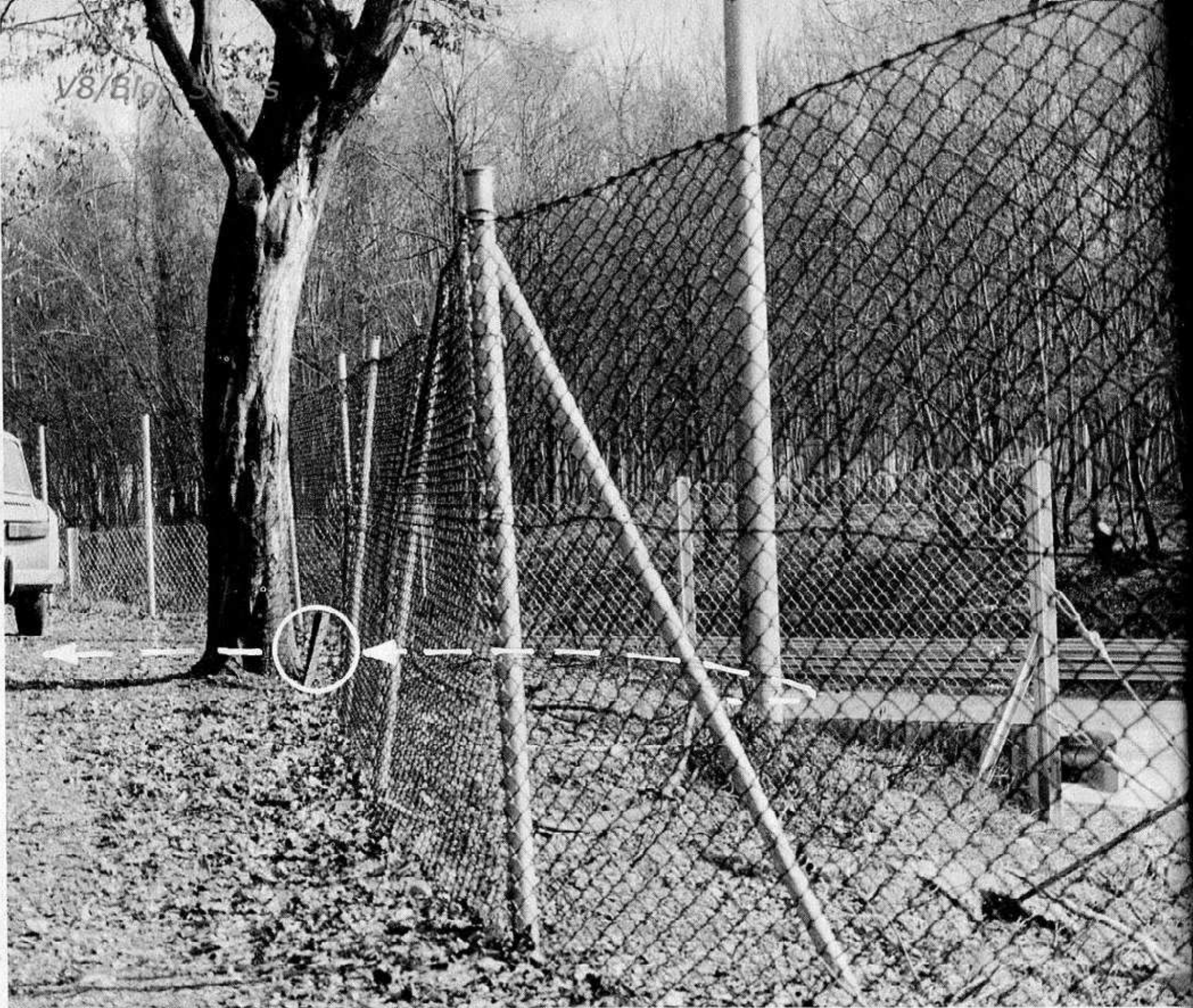
Il primo picchetto, adiacente alla rete, indica il punto in cui la pista devierà dalla sua attuale sede visibile a destra in basso, per arrampicarsi sul dosso che la fiancheggia (gli alberi saranno tagliati)
